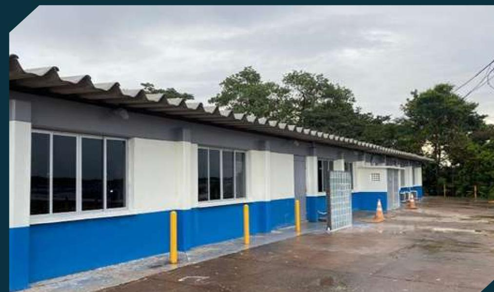
SUBSTITUIÇÃO DE COBERTURA EM FIBROCIMENTO TIPO KALHETÃO (COBERTURA ANTIGA COM AMIANTO);
