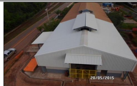
Ampliação do Torno Subsolo TAG 020 – VALE
