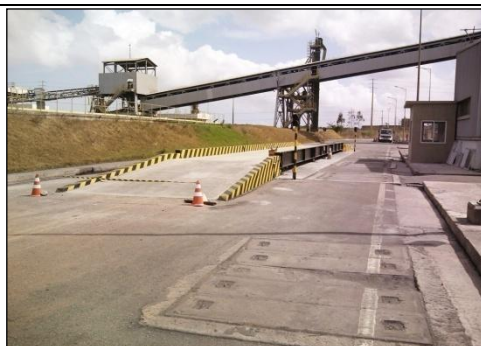
Construção da Balança Rodoviária na UTE-ITAQUI - ENEVA
