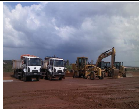
Manutenção de vias e processos erosivos – PETROBRAS
