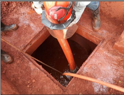
Serviços de limpeza do sistema de drenagem - ALUMAR
