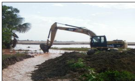
Execução de canal a céu aberto – PETROBRAS
