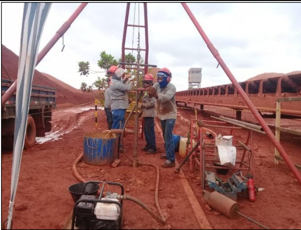
Serviços de sondagem na área de Pátio de Bauxita - ALUMAR
