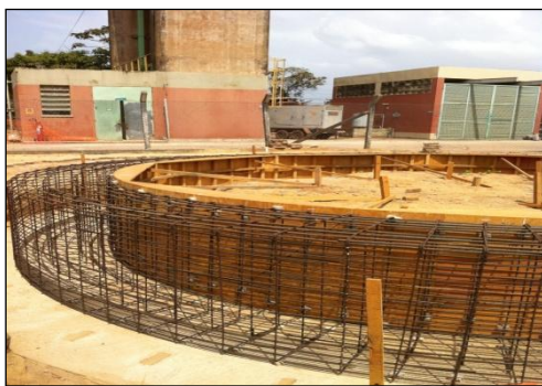
Base para tanque de água de incêndio – VALE
